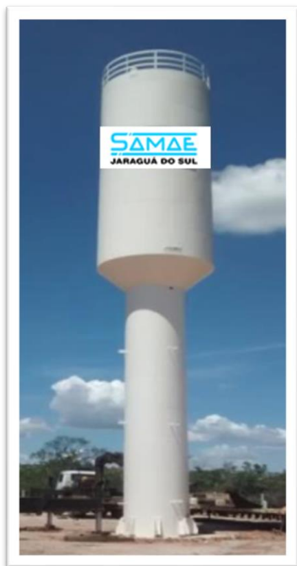
Figura 01: Imagem do Reservatório em aço carbono, do tipo taça com coluna seca
